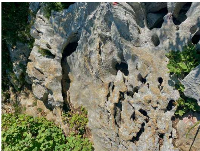
Slika 3: Korozijsko delovanje na kraškem površju (foto: Sara Jemec).
