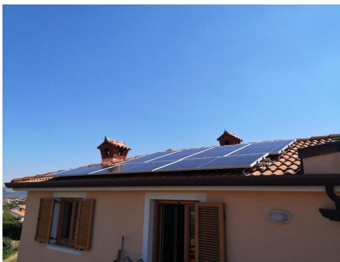
Slika 1: Strešna sončna elektrarna (foto: Matej Knez).
