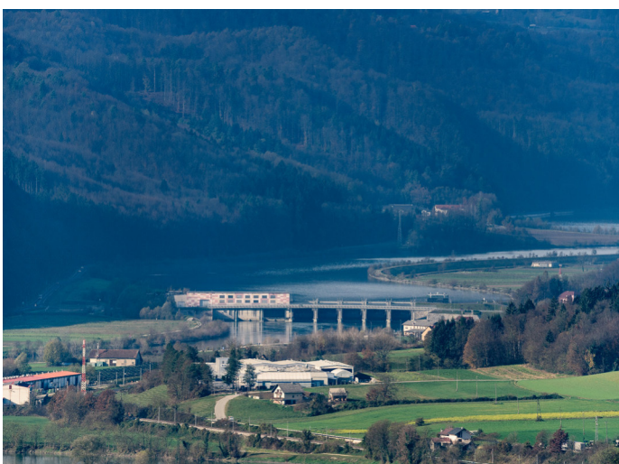
Hidroelektrarna Blanca (foto: Darko Jakovac).
