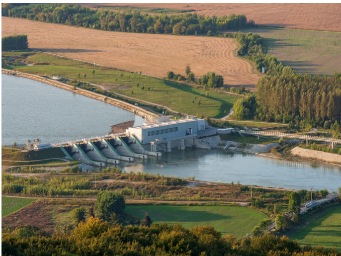
Hidroelektrarna Brežice (foto: Darko Jakovac).
